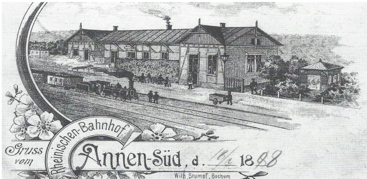
Der Bahnhof in Annen-Süd wurde wegen der geographischen Verhältnisse versetzt angeordnet. Die Bahn errichtete das Empfangsgebäude ganz auf der Westseite, sodass die Anlagen für den Güterverkehr um ca. 300-400 Meter nach Osten verschoben wurden. Das Empfangsgebäude bestand aus einem eingeschossigen Fachwerkbau. Die Schalterhalle erreichten die Fahrgäste über eine kleine Treppe vom Vorplatz aus. Dahinter befanden sich die Wartesäle 1./2. Klasse und 3./4. Klasse.
